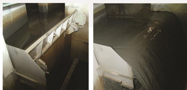
HydroBend Overfaldskant i kloak, ikke behov for elektricitet.
